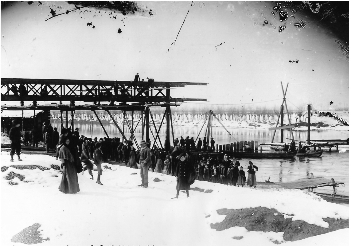
1908/9 - Costruzione del ponte sul fiume Oglio tra Calvatone ed Acquanegra S/C.
