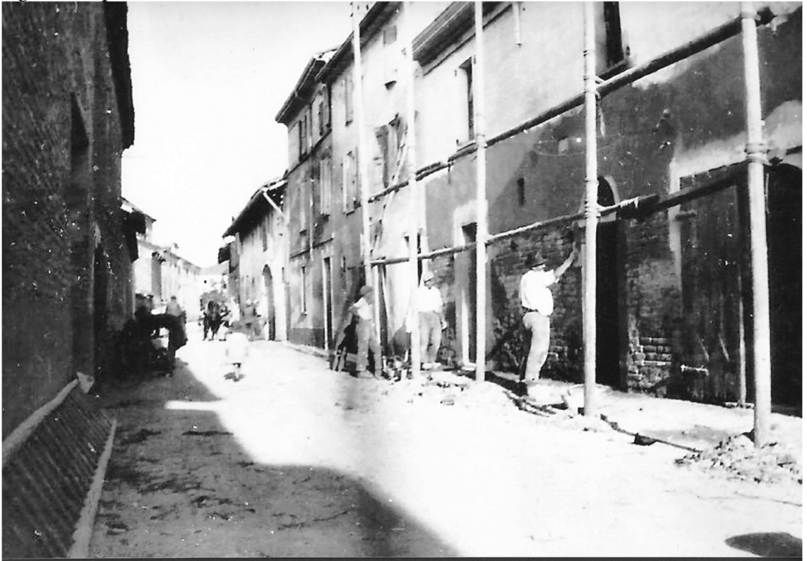
Ponteggi in via Roma per la ristrutturazione della casa Arnoldi/Piccinelli (Franco Barili).
