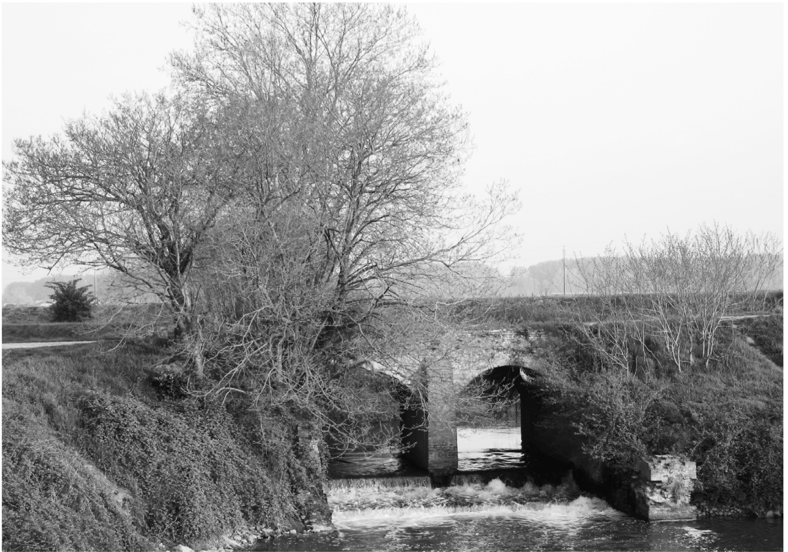
Ponte storico sul canale Delmona in località S. Andrea.
