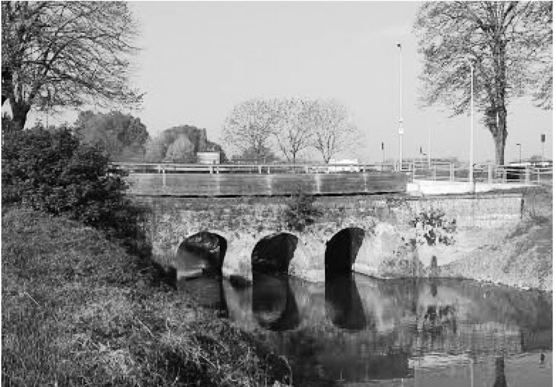
Il ponte del cimitero.
