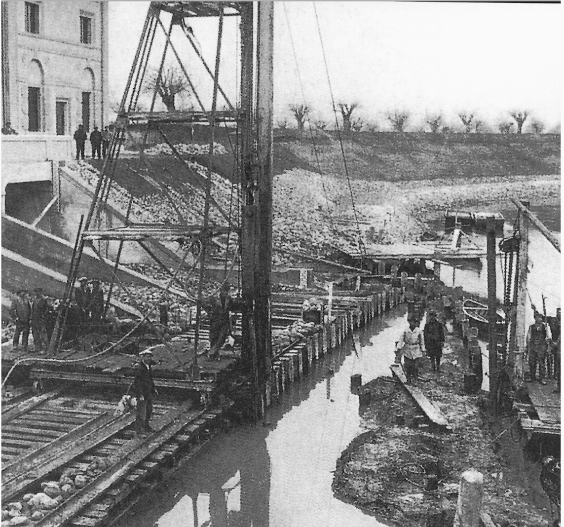
Anni '30 - La costruzione dell'impianto di sollevamento acqua in località S. Maria.
