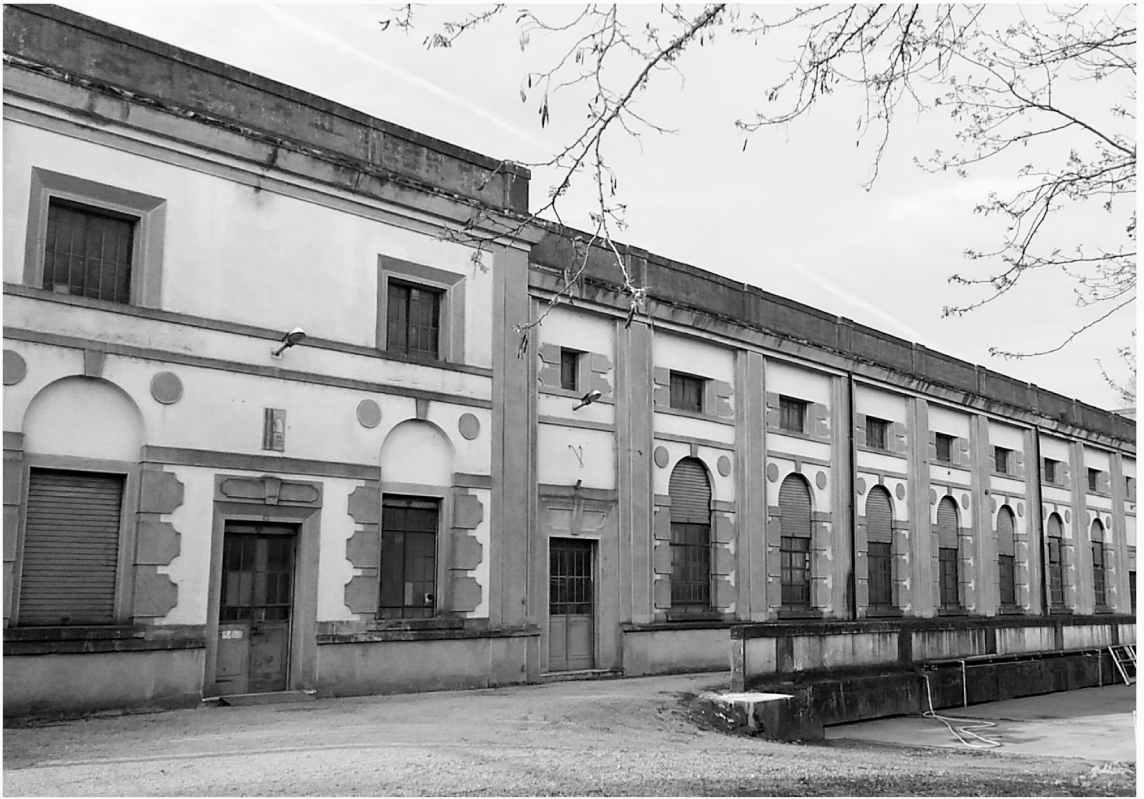
Impianto di sollevamento acqua dal fiume Oglio in località S. Maria (Mulin).
